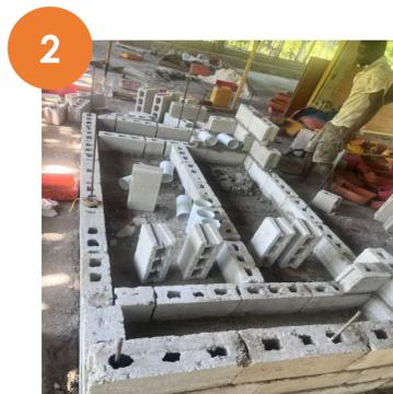
2 Construcción de la base de concreto para el contenedor.
